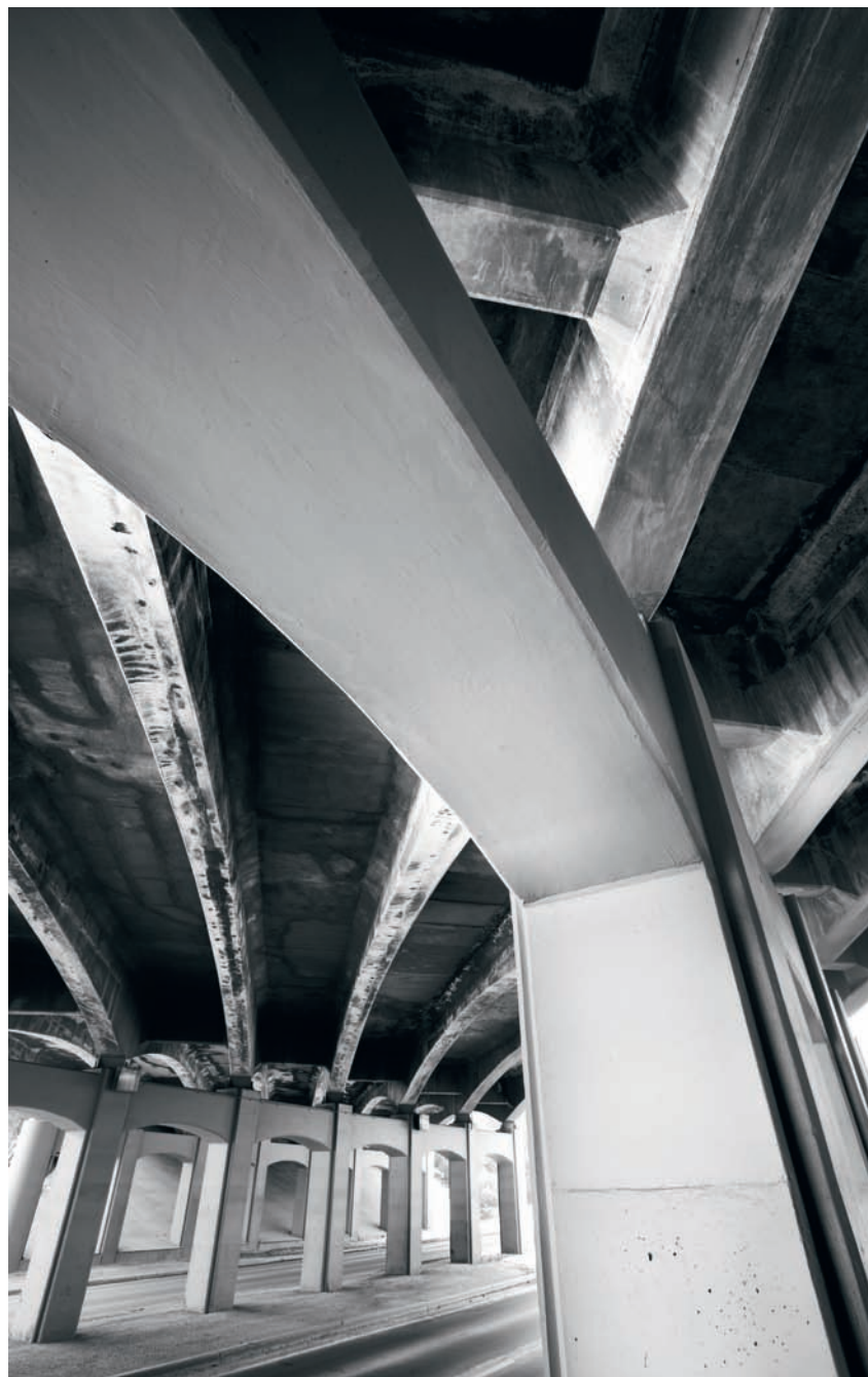
▲ Zdjęcie 4.: Przejazd podziemny
