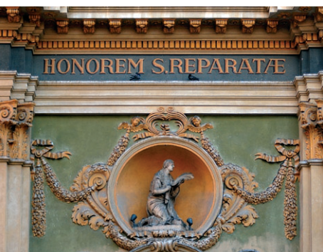
■ Zdobienie fasady katedry św. Reparaty w Nicei
