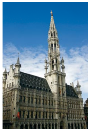
Budynek brukselskiego ratusza
