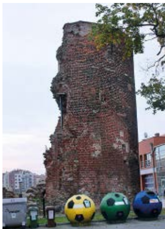
▲ Bastion Pod Zębem
