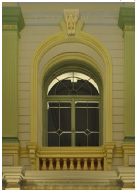
Okno hali głównej
