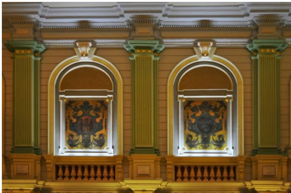
Detale hali głównej
