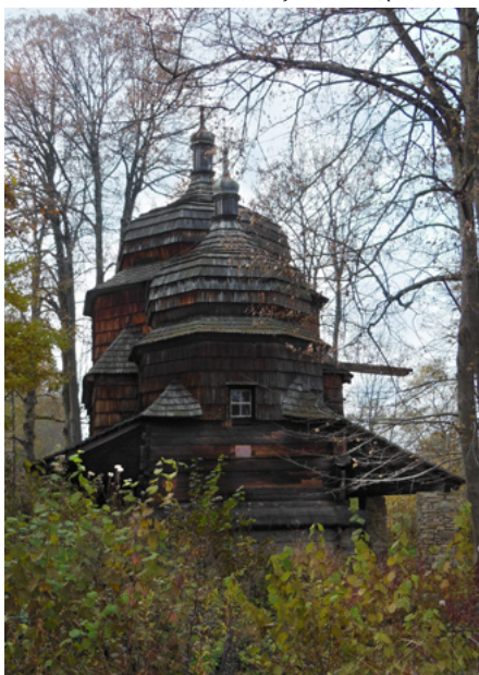
Elewacja wschodnia, prezbiterium
