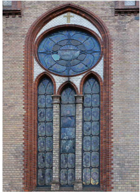
Okno (triforium) w transepcie (elewacja północna)
