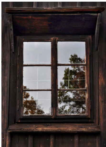
Okno w nawie, elewacja południowa
