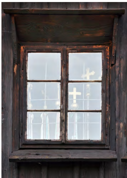
Okno w nawie, elewacja północna
