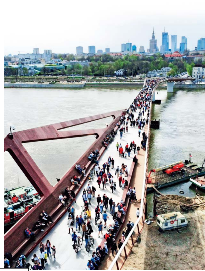
27 Na wojennej kładce
