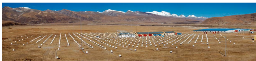
Siec 733 liczników scyntylacyjnych pozwala określić kierunek, z którego nadleciał wysokoenergetyczny promień, z dokładnością większą niż 1 stopień kątowy.
