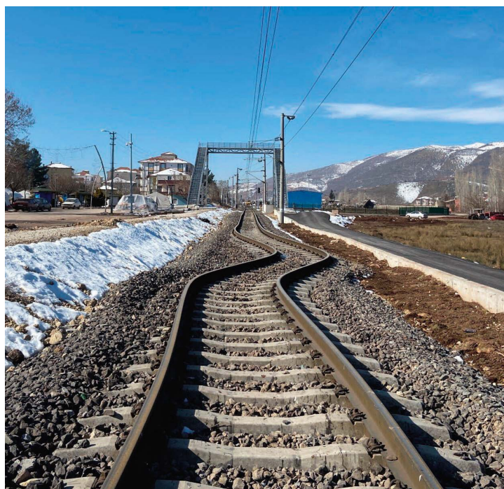
Tor kolejowy na południu Turcji zdeformowany podczas silnego trzęsienia ziemi w lutym 2023 r. W tym miejscu ziemia przesunęła się w poziomie o ponad 2 m.
