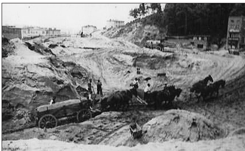
Konie na budowie portu gdyńskiego.
