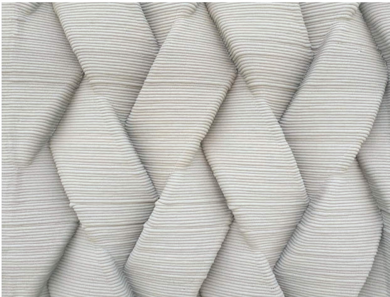
RYСУNEK 3.17. Przykład nietypowej betonowej ściany budynku mieszkalnego, wzniesionej przy użyciu drukarki 3D
