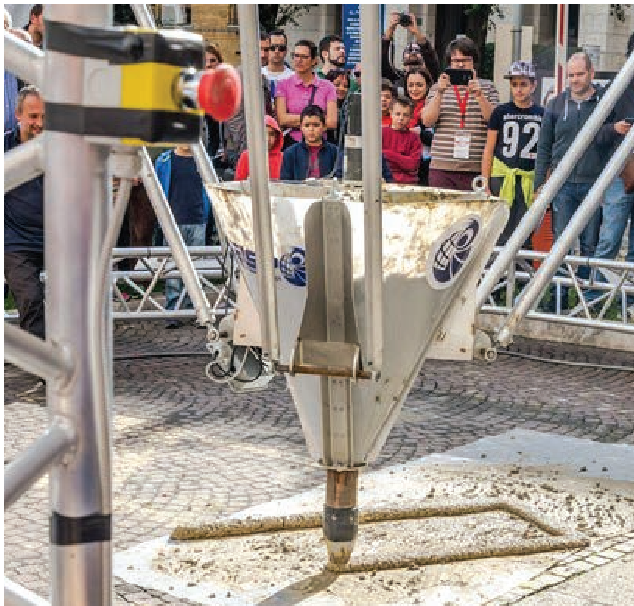
RYСУNEK 3.16. Rzym, Włochy. Wielka, przemysłowa drukarka 3D tworzy cementową konstrukcję bez udziału pracowników. Drukarka jest sterowana programem komputerowym
