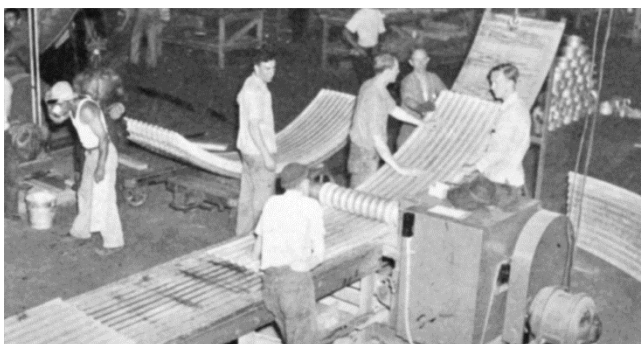
Rys. 2.2. Proces zakrzywiania blach profilowanych (1941) [3]
