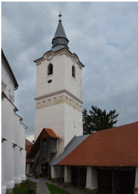
Wieża, elewacja północna i zachodnia
