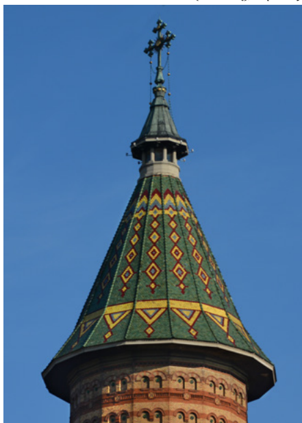
Wieża centralna (nad nawą), od północy
