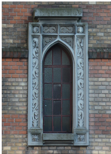
Okno elewacji północnej
