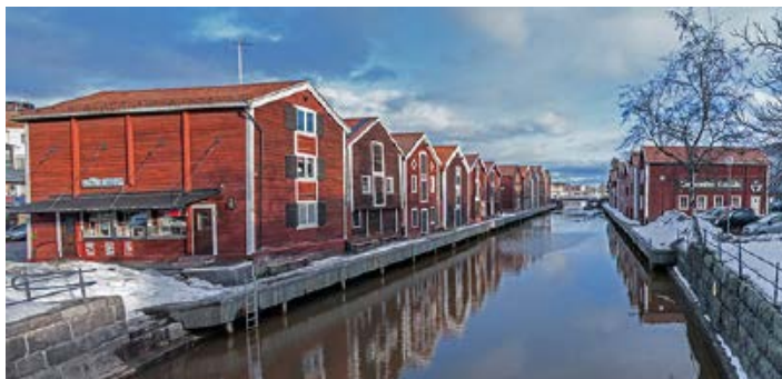
▲ Stare magazyny w Hudiksvall
