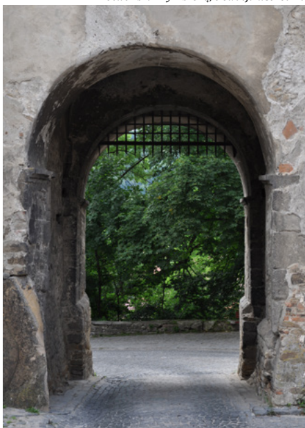
Otwór bramny z broną, elewacja wschodnia
