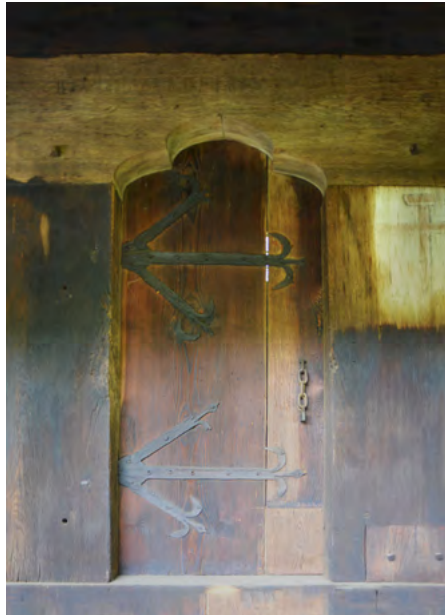
Wejście boczne do nawy (elewacja południowa)
