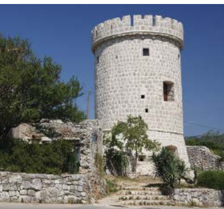
▲ Pozostałości murów obronnych
