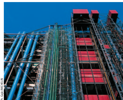
Różne przeznaczenie – różne barwy: zielony to kolor instalacji wodnych, biały – przewodów wentylacyjnych, błękitny – klimatyzacji, żółty – instalacji elektrycznych, czerwony – klatek schodowych i korytarzy
