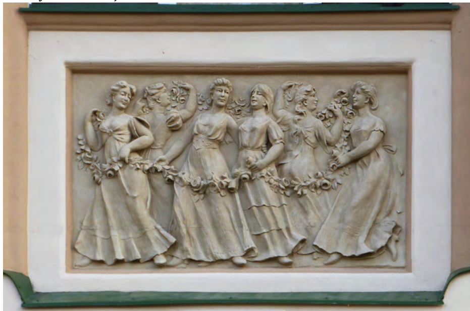
Stukowe reliefy, elewacja zachodnia
