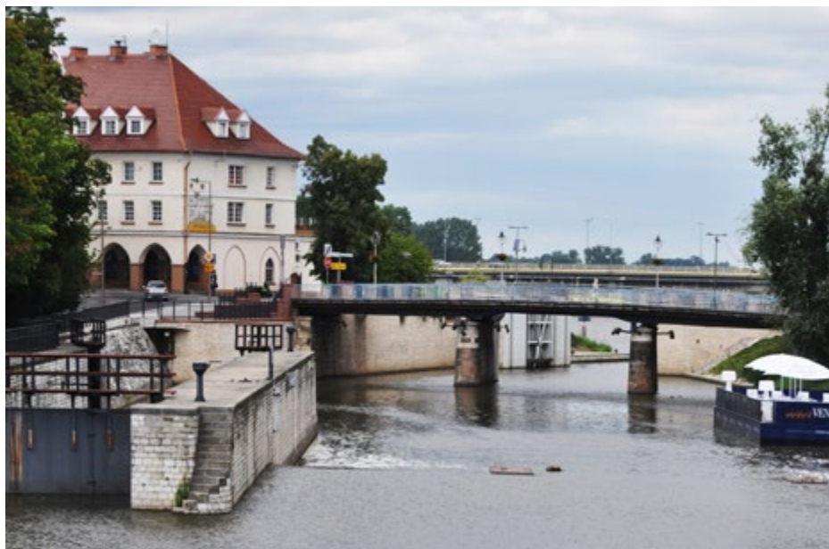
Zabudowania nad kanałem Młynówka, brzeg zachodni
