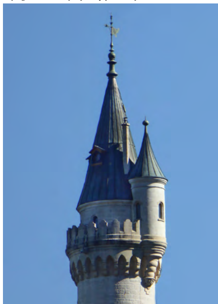
Część górna ośmiokątnej wieży północnej
