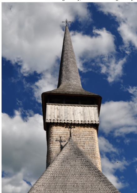
Dach gontowy, wieża z dachem gontowym
