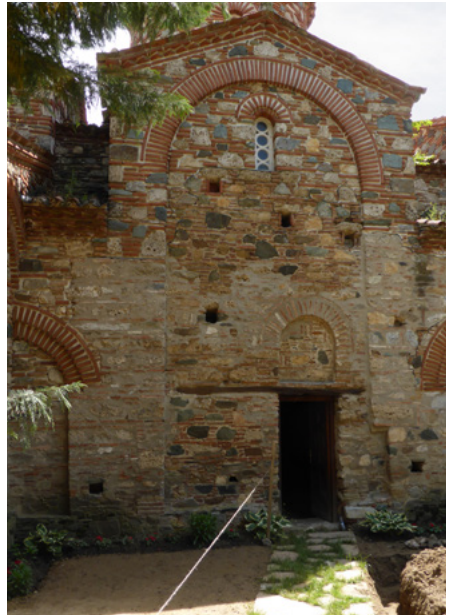
Elewacja północna, wejście do kruchty
