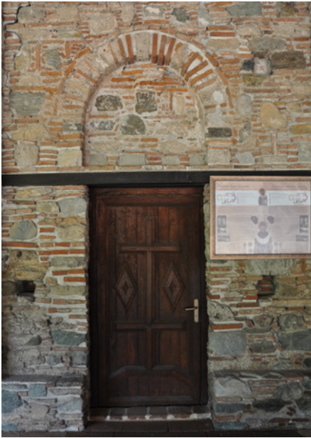
Elewacja południowa, wejście do przednawia
