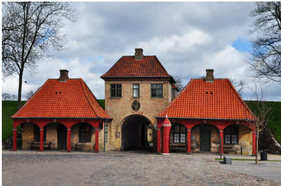
Brama północna (Norweska), elewacja południowa
