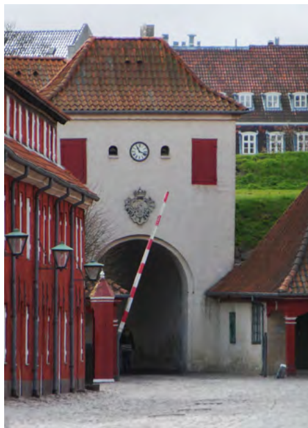
Brama południowa (Królewka) elewacja północna
