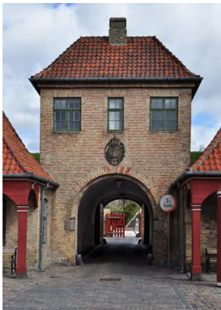
Brama północna, elewacja południowa
