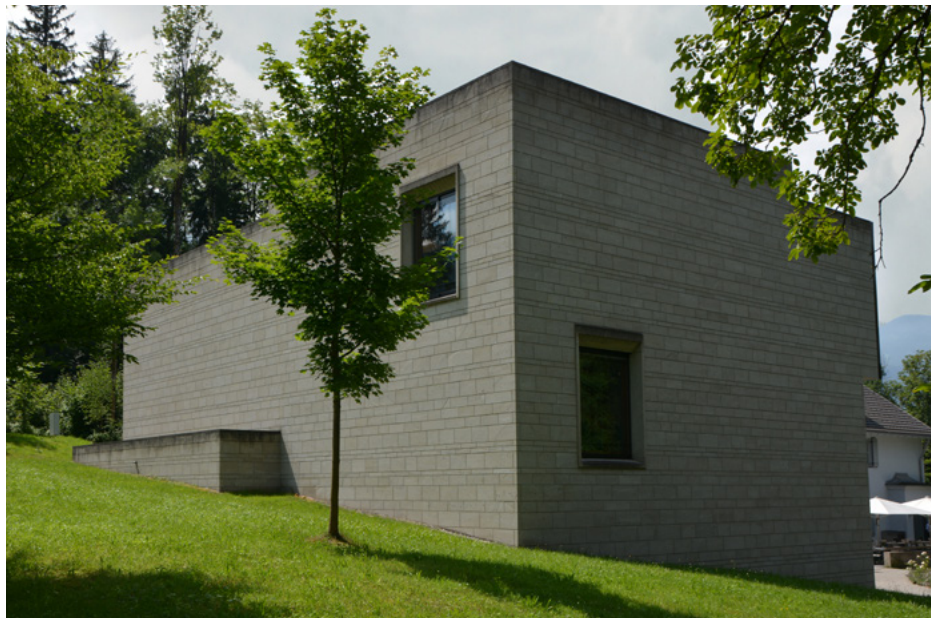
Nowy budynek (z 2008), zaprojektowany przez architektów szwajcarskich
