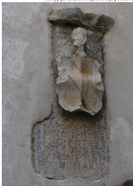
Inskrypcja na dzwownicy, elewacja północna
