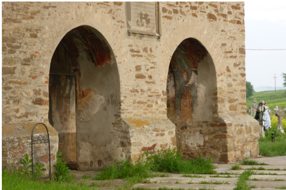
Arkadowe przejścia narteksu
