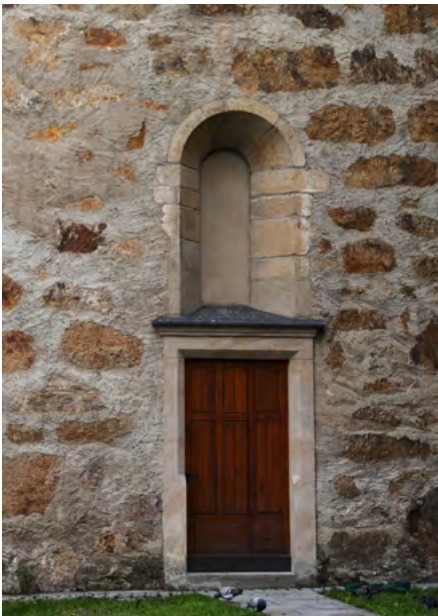
Drzwi do dzwonnicy, od wschodu
