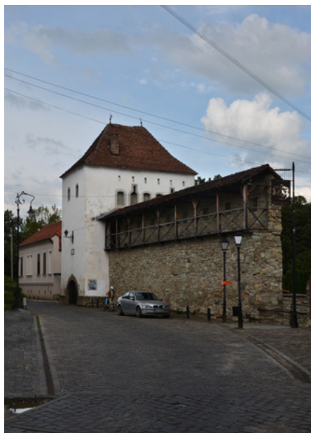
Fragment murów, elewacja północna
