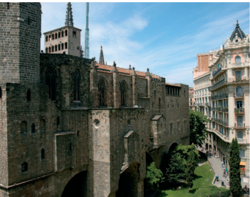
Zabytkowa architektura Barri Gòtic
