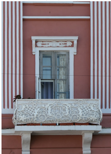
Balkon kamienicy nr 10, w pierzei południowej
