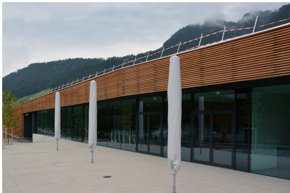
Centrum Kongresowe, elewacja południowa
