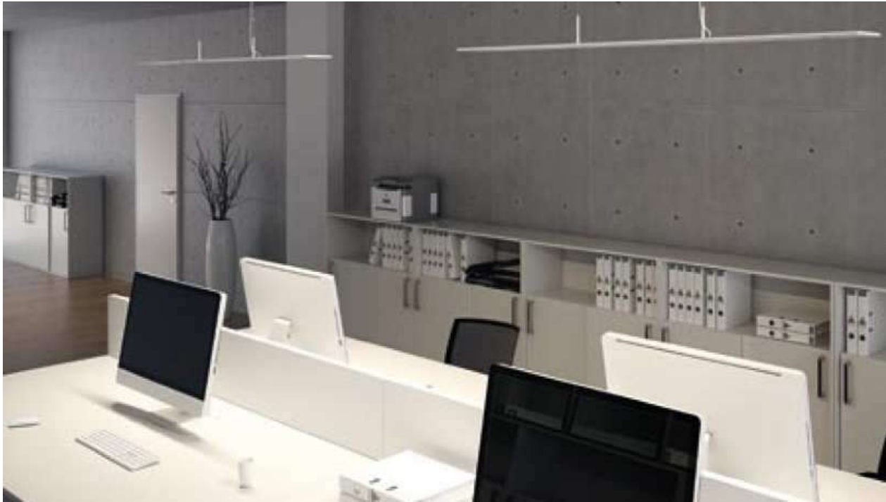
Rys. 1. Stanowiska pracy z monitorami ekranowymi – widoczne zawieszone wysoko oprawy oświetleniowe [OSRAM]
