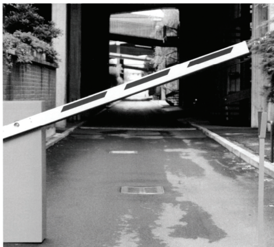
Fot. 1. Szlaban z napędem elektromechanicznym
