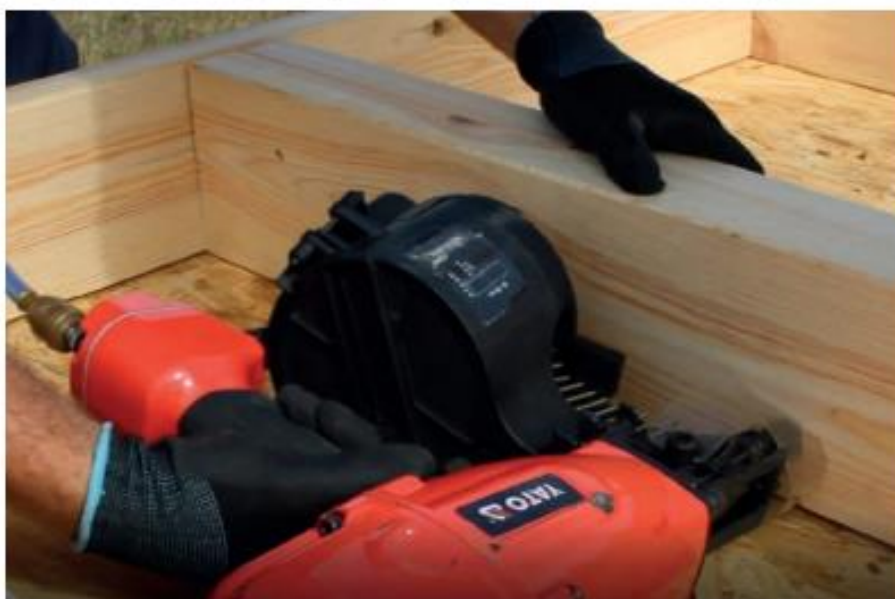
Zbijanie ścian domku gwoździarką
