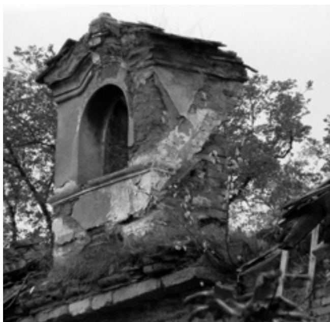
RZAŚNIK. Destrukcyjność lukarny na pałacowym dachu. Zdjęcia z lat 2012 i 2014
